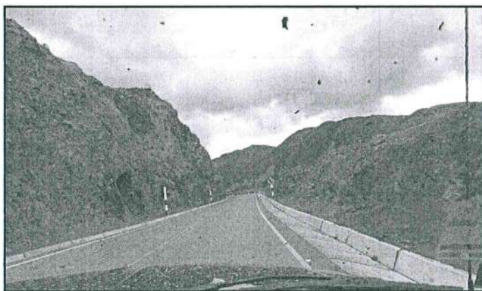
Foto 1: Carretera a Llama y La Colmena.
